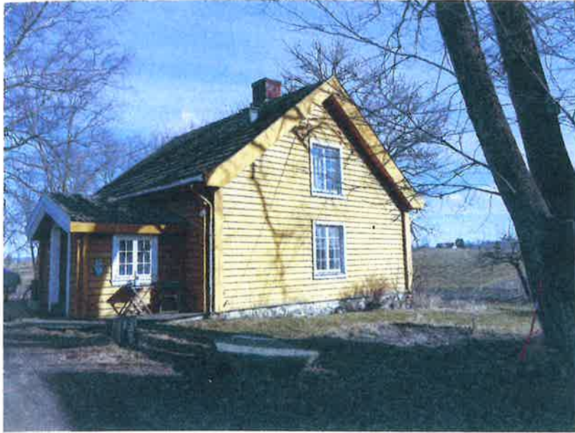
Foto 6: Kårstua, Et lafta hus kledd med utvendig panel. Fasaden var opprinnelig rappet. Senere restaureringer er foretatt i 1900 og 1975. Foto: NIKU, 2022.
