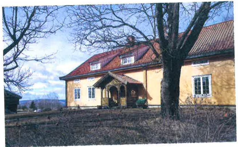
Foto 5: Våningshuset fra 1733 med nyere inngangsparti i sveitserstil. Bygningen er istandsatt med ny grunnmur, nytt tak, reparerte vinduer etc. Husets romstruktur med store værelser er intakt. Foto NIKU, 2022.
